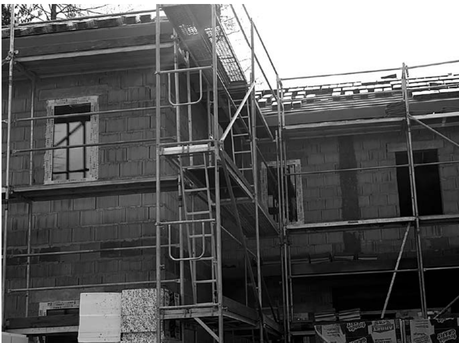
Budowa żłobka, fot. Kurier Kowarski
