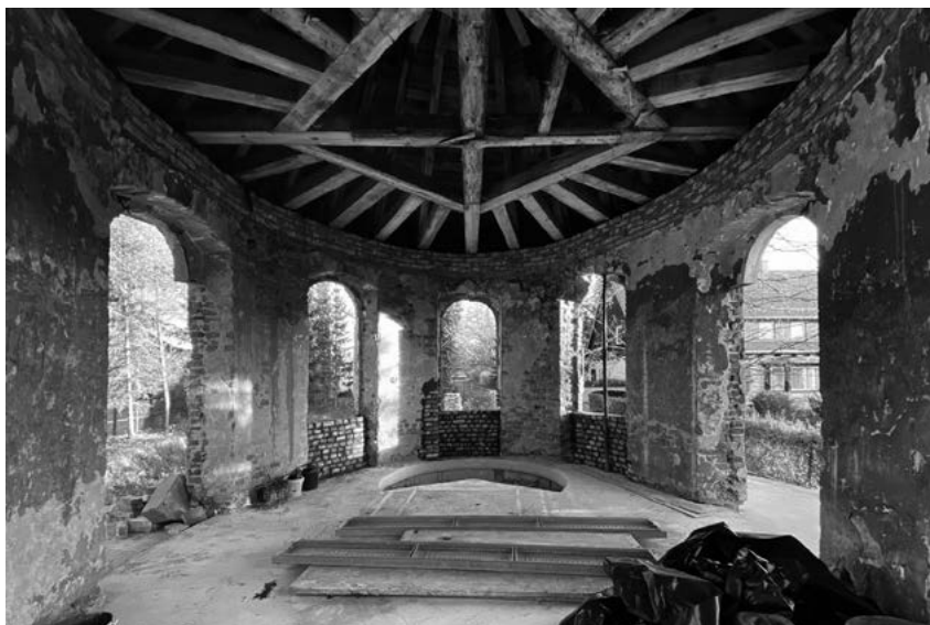
Prace remontowe: odnowiona więźba dachowa, nowy strop 1. kondygnacji
