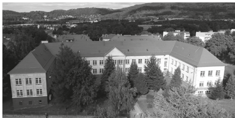
Budynek Liceum, fot. Kurier Kowarski
