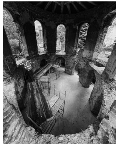
Wnętrze podczas remontu
