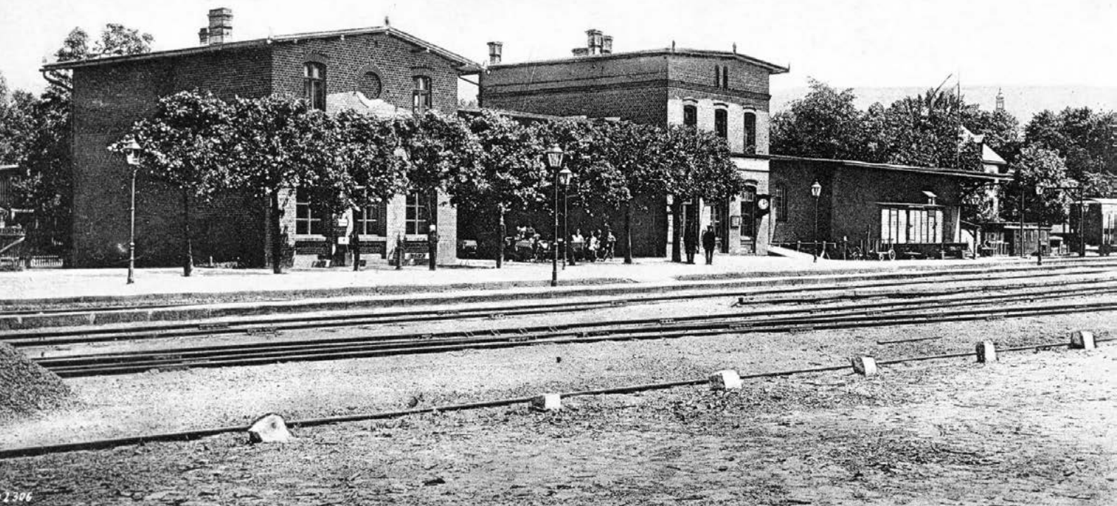
Budynek dworca kolejowego w Kowarach, ok. 1905–1908, widokówka ze zbiorów Mateusza Śmigłego
