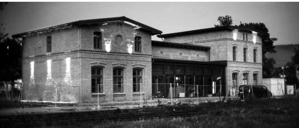
Wyremontowany dworzec w Kowarach od strony torów i miasta
